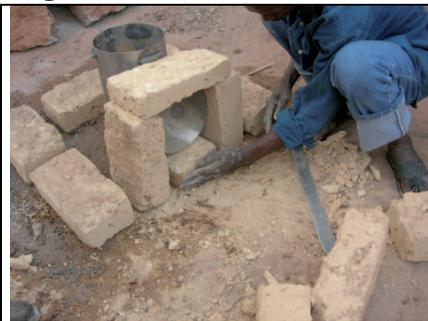
Il peut être nécessaire de couper les briques verticales, et un morceau pour ajuster autour de l'ouverture comme sur la photo.
