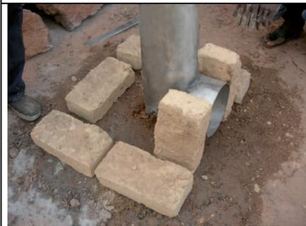
Mettre en place le tube bien verticalement et disposer le premier rang de briques.
