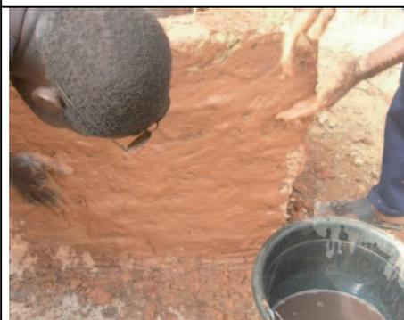
On couvre ensuite, avant qu'elle ne sèche, la partie basse extérieure d'un enduit de terre, lissée à la main
