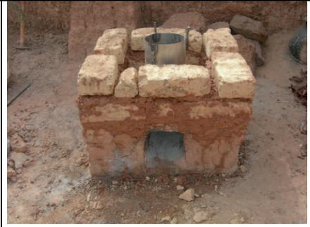
On poursuit avec le quatrième et le cinquième rang. Le dernier niveau de brique doit arriver juste un peu au-dessous du haut du tube.
